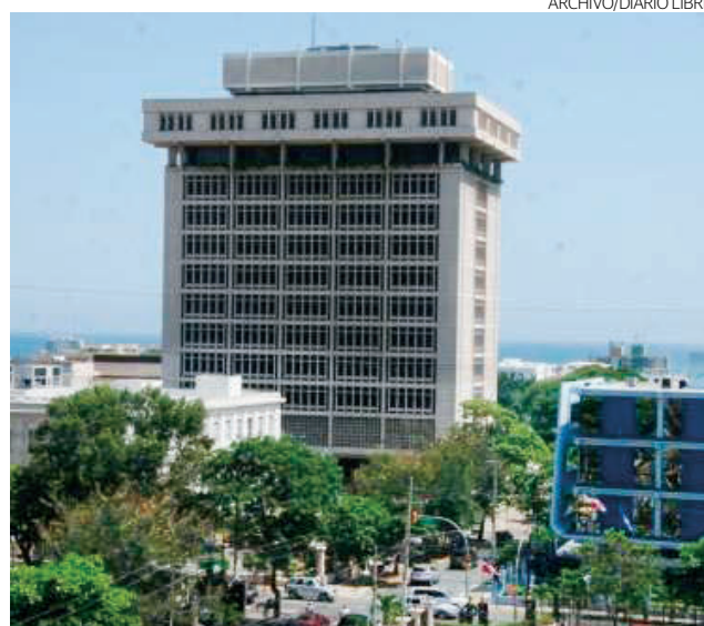
Edificio del Banco Central de la República Dominicana.
